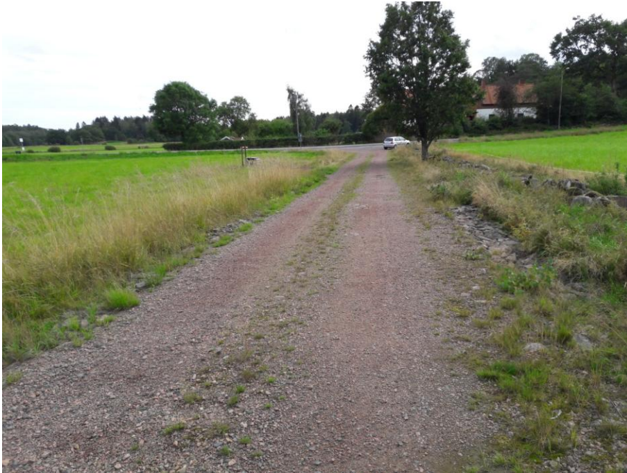
Bild B Korsningen med Norra Hällesåkersvägen sedd från befintlig väg till området (2019)
